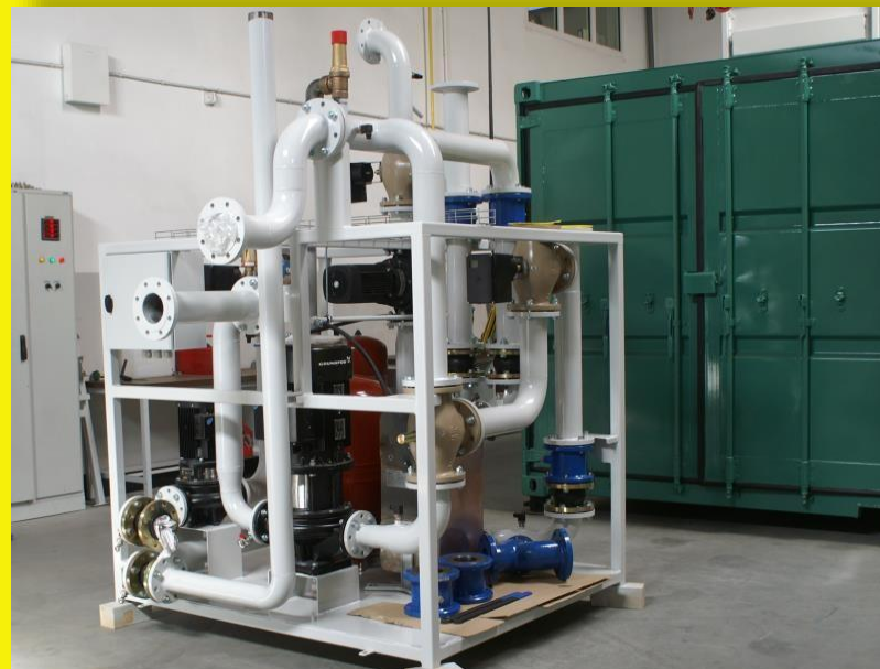
Widok poglądowy kompaktowego modułu odzysku ciepła
