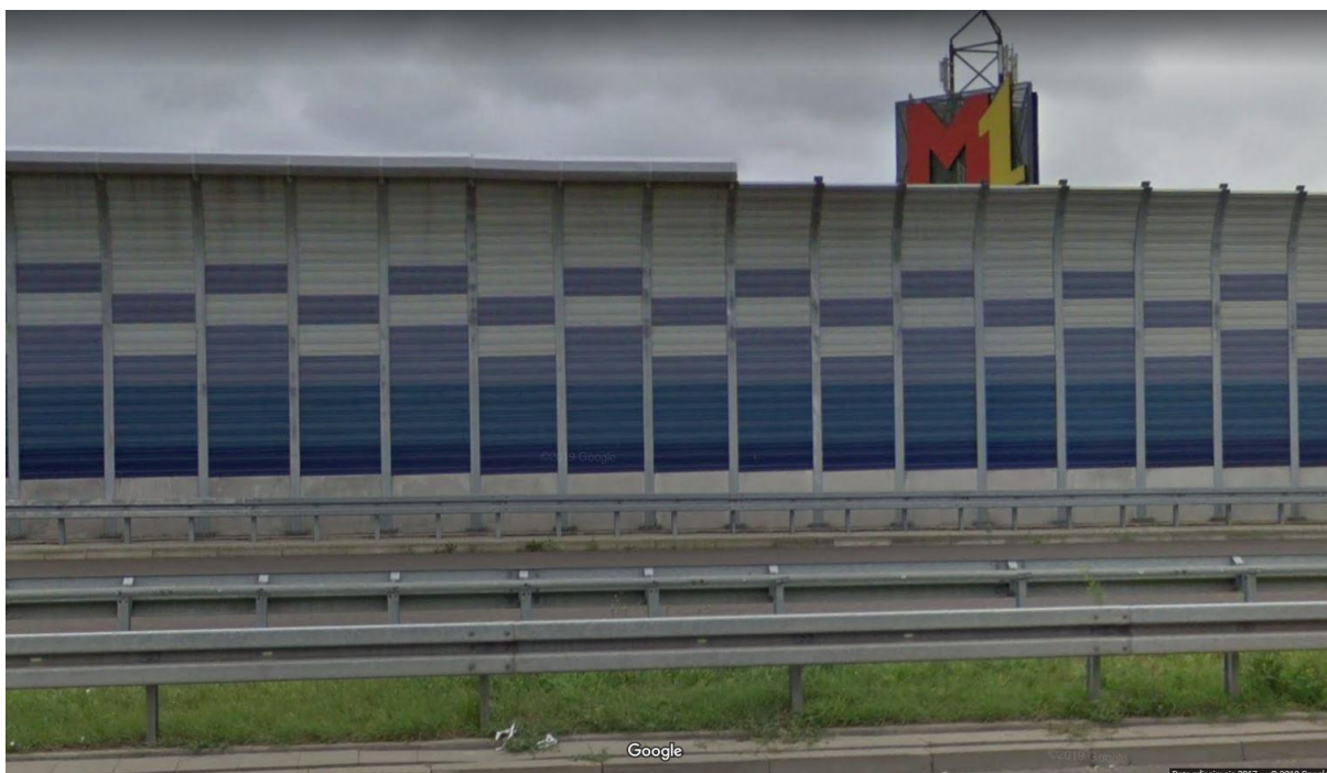
Fot. 3 Ekran akustyczny z zamontowanym oktagonem przy trasie S8, węzeł Piłsudskiego w Warszawie (źródło: https://www.google.com/maps )
