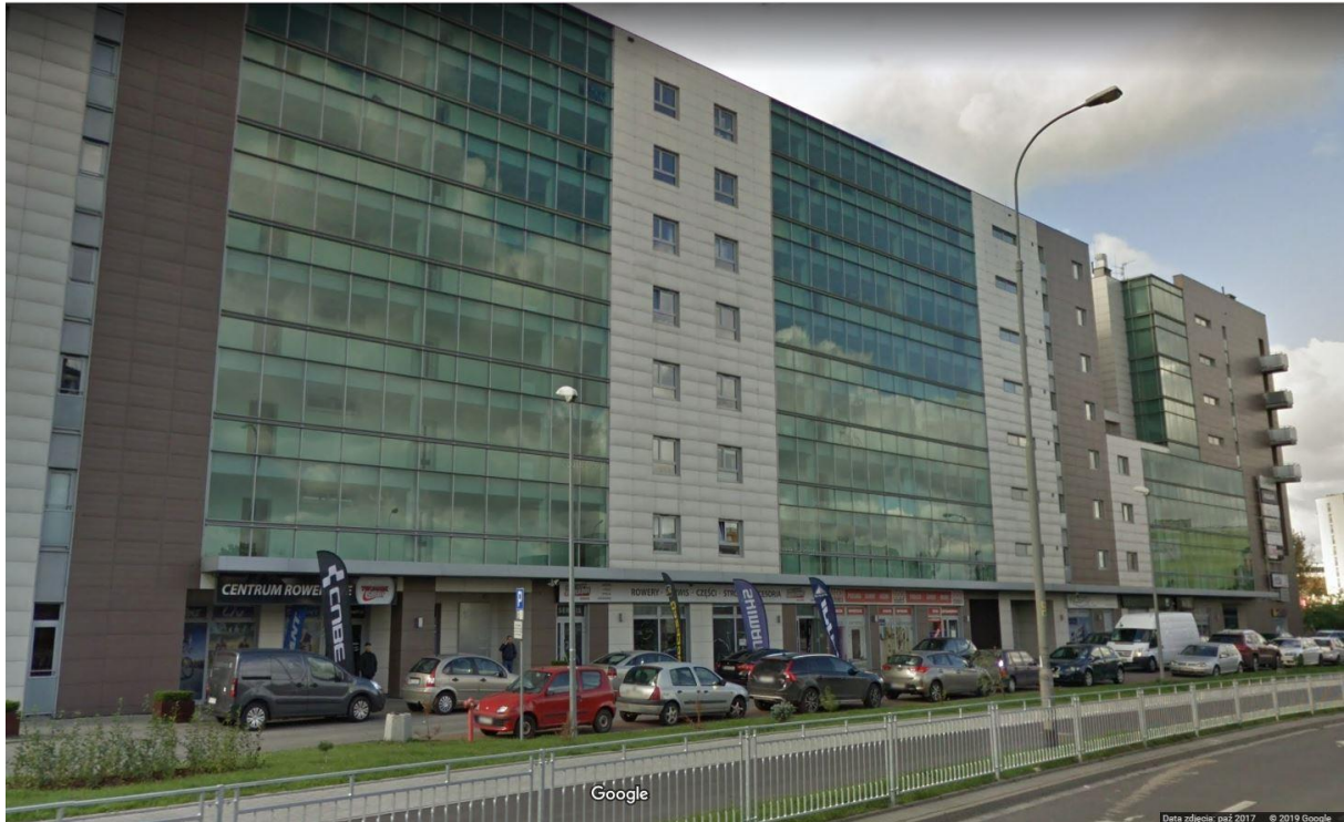
Fot. 4 Budynek z ekranami akustycznymi na elewacji – ul. Hallera (DK 5) we Wrocławiu (źródło: https://www.google.com/maps )
