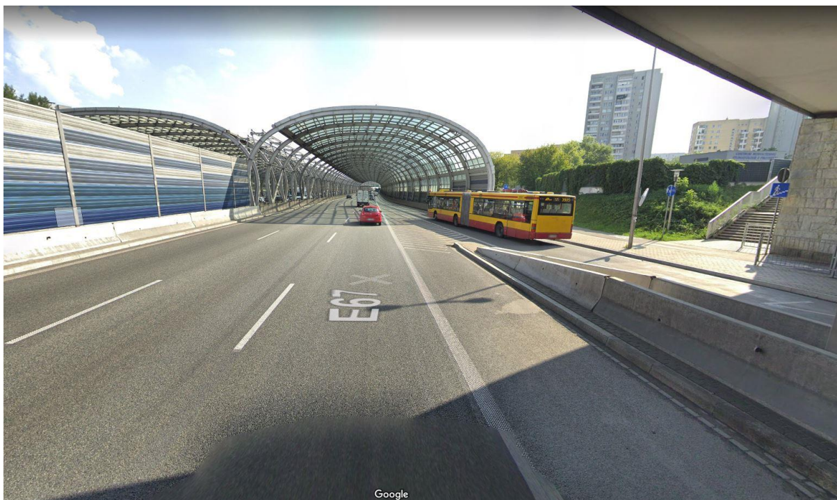
Fot. 2 Półtunele akustyczne na trasie S8 – Aleja Armii Krajowej w Warszawie (źródło: https://www.google.com/maps )
