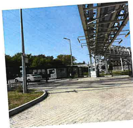
Badany teren wokół stacji 220/110 kV Praga
