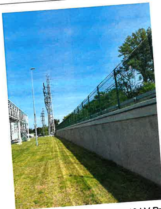
Badany teren wokół stacji 220/110 kV Praga
