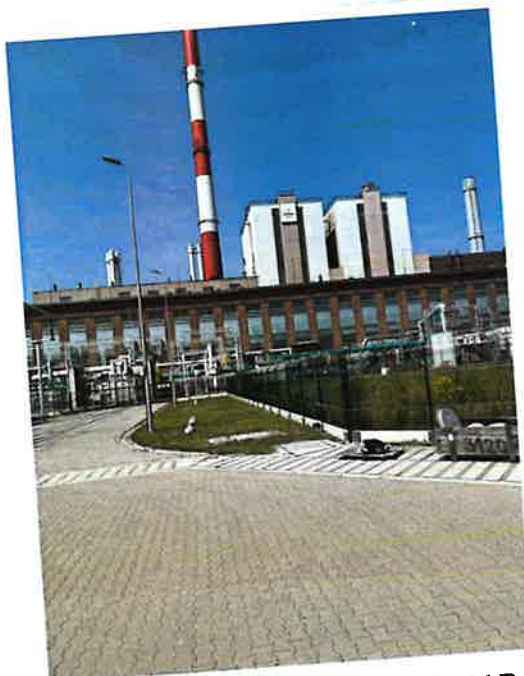
Badany teren wokół stacji 220/110 kV Praga
