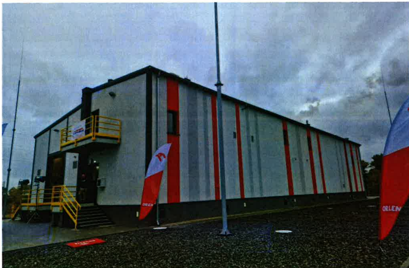
Zdjęcie 1 Badany obiekt
