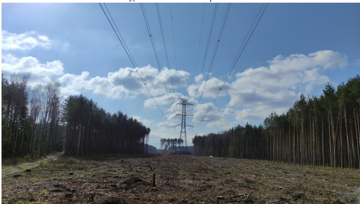
Zdjęcie nr 14. Widok na słup nr 117.
