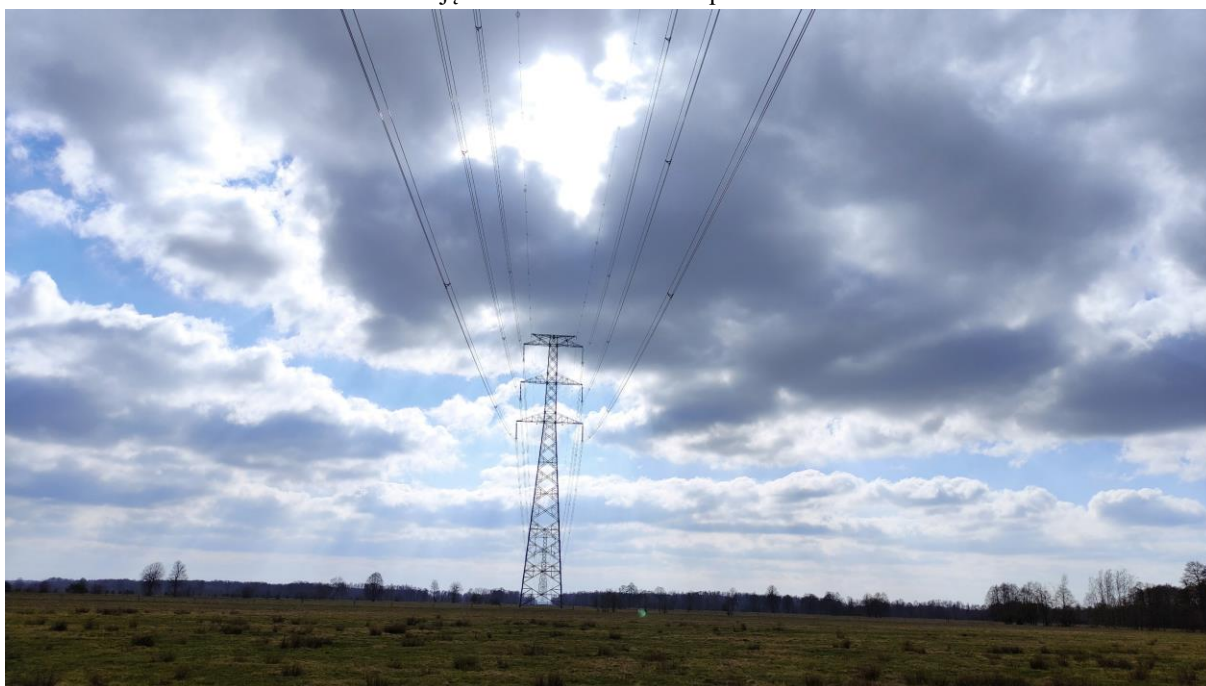
Zdjęcie nr 12. Widok na słup nr 85.
