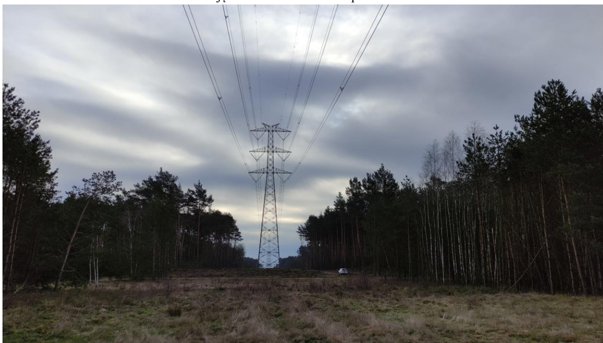
Zdjęcie nr 18. Widok na słup nr 146.
