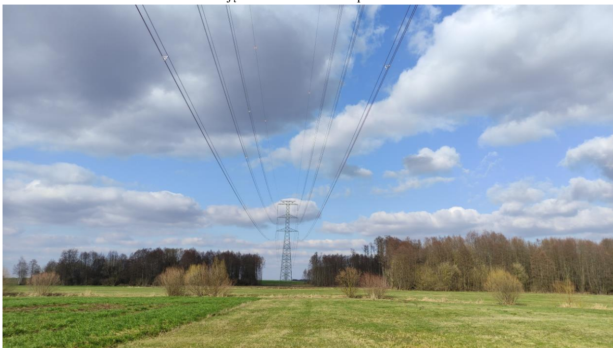
Zdjęcie nr 8. Widok na słup nr 41.
