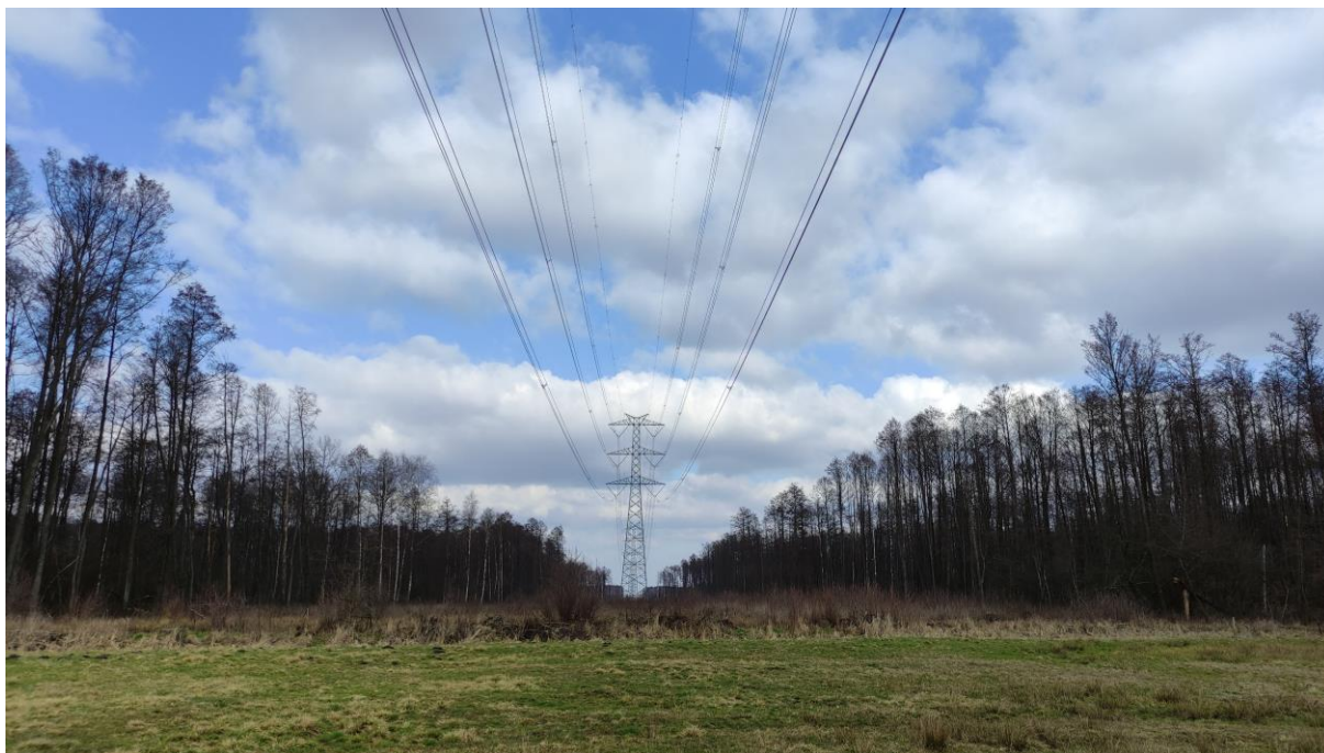
Zdjęcie nr 11. Widok na słup nr 84.
