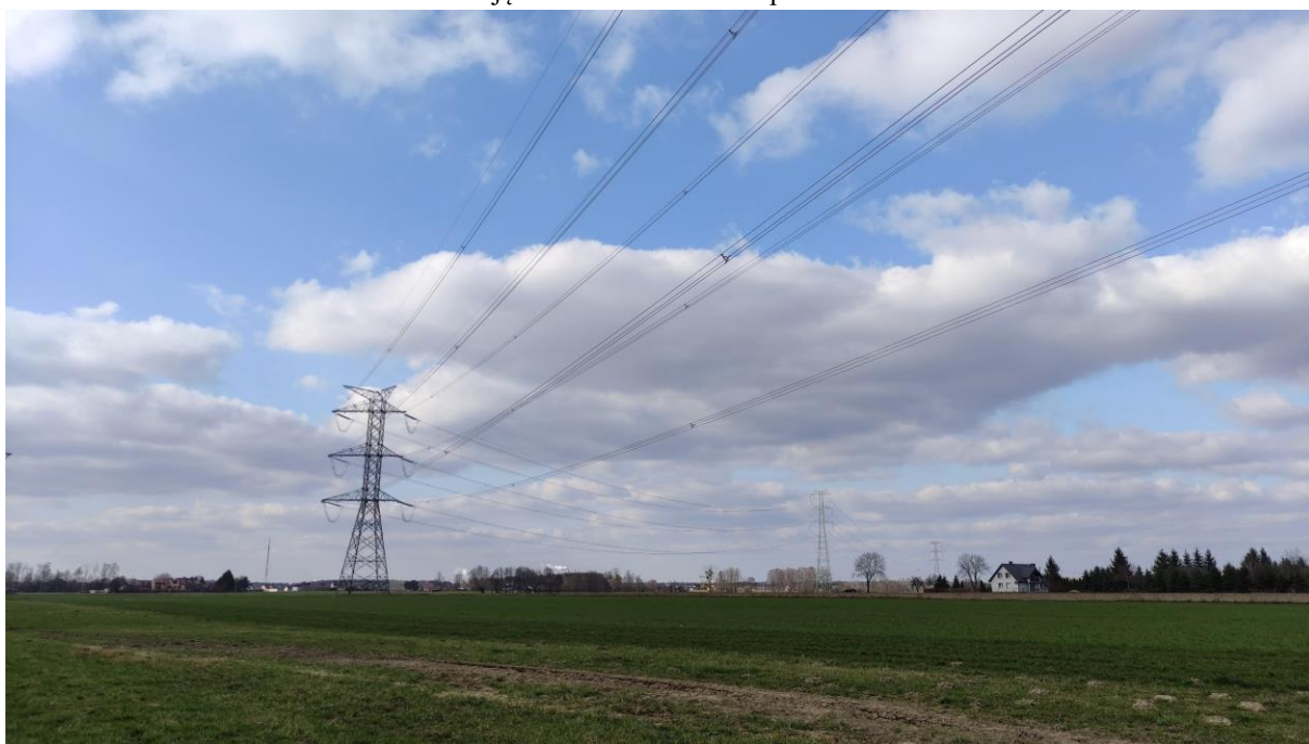
Zdjęcie nr 6. Widok na słup nr 16.
