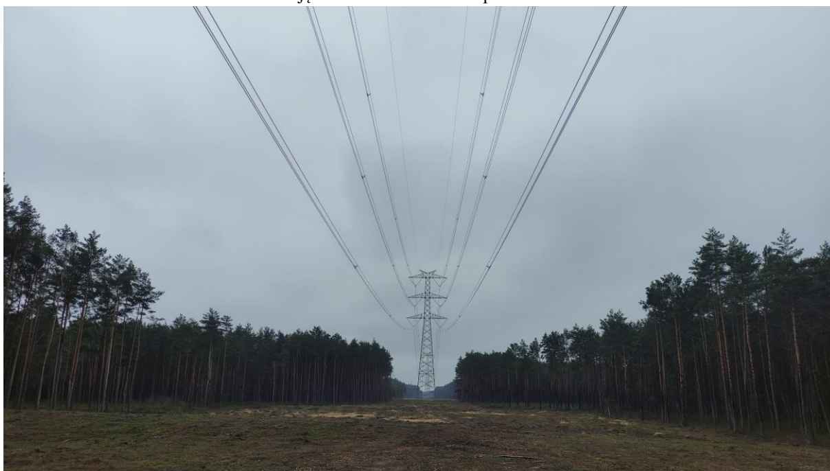
Zdjęcie nr 24. Widok na słup nr 204.
