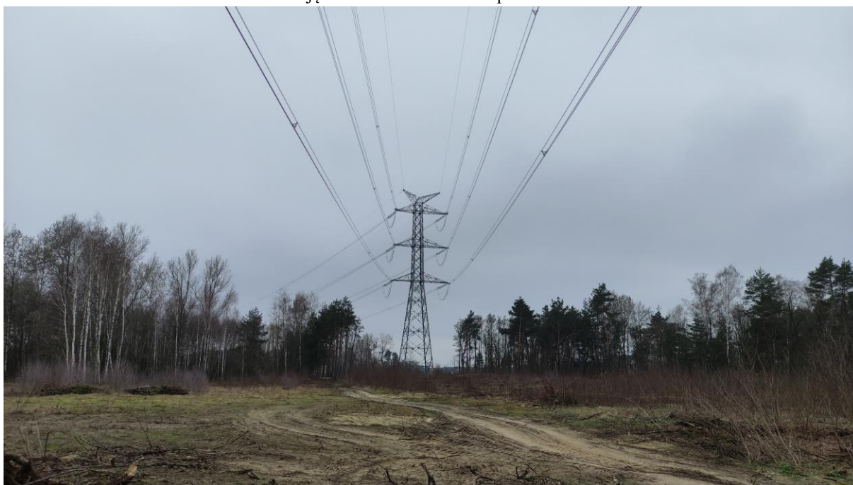
Zdjęcie nr 22. Widok na słup nr 186.
