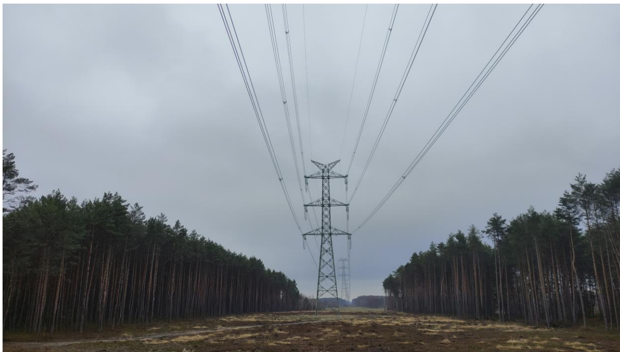
Zdjęcie nr 23. Widok na słup nr 203.
