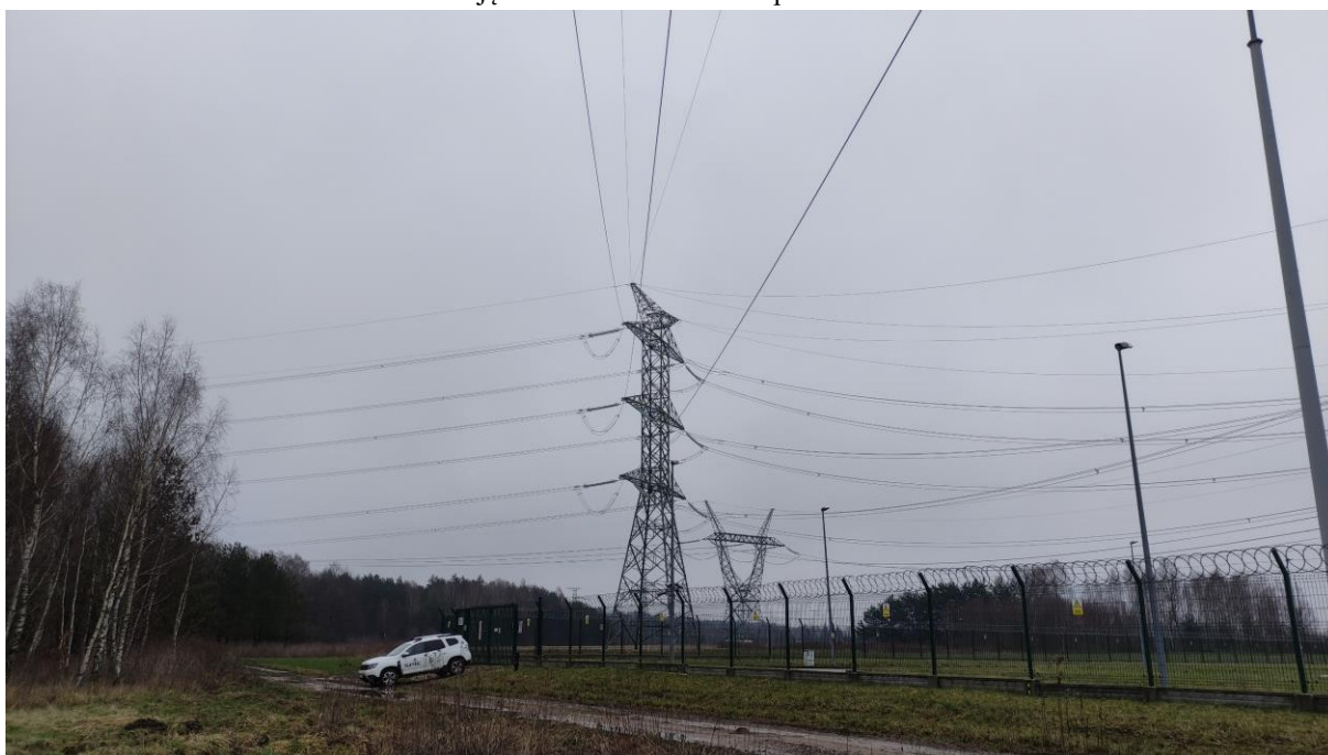
Zdjęcie nr 28. Widok na słup nr 56A.
