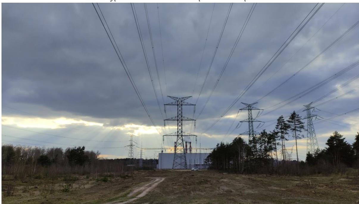
Zdjęcie nr 4. Widok na słup nr 1.
