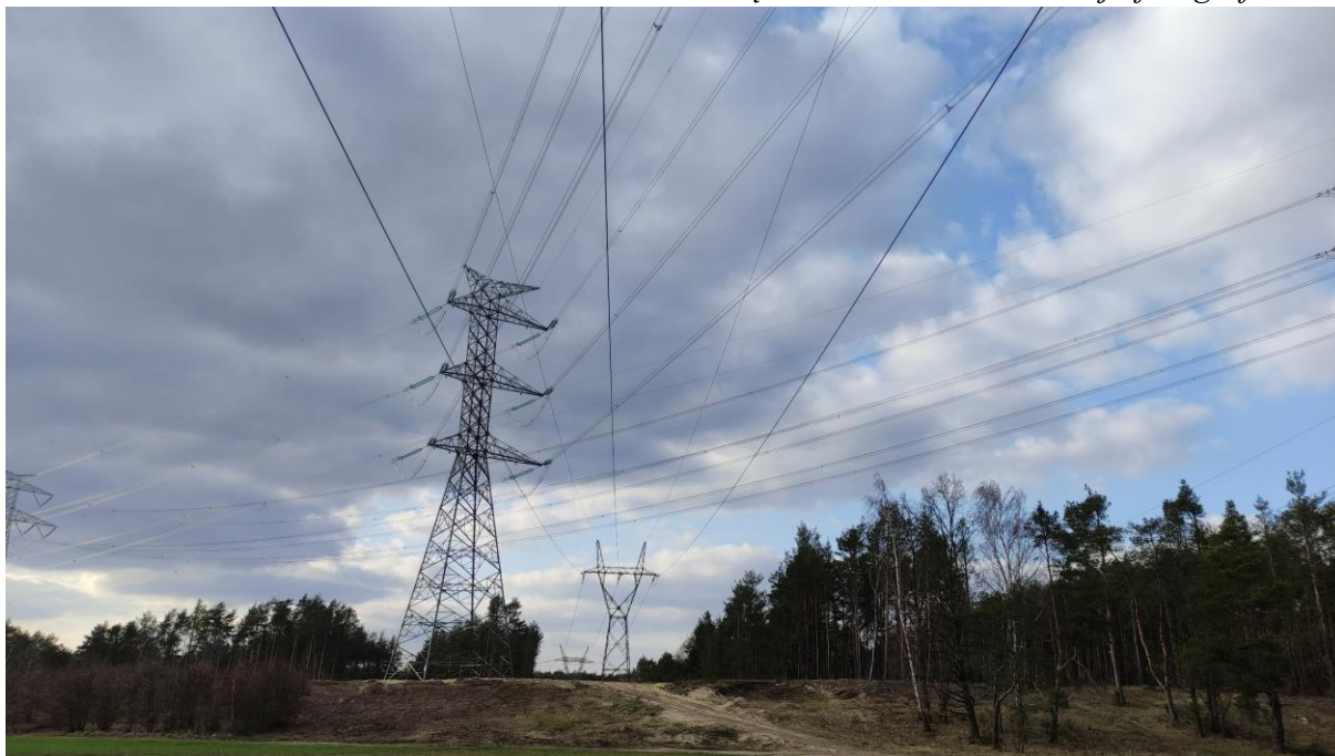
Zdjęcie nr 1. Widok na słup nr 323.
