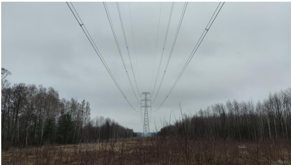
Zdjęcie nr 21. Widok na słup nr 185.
