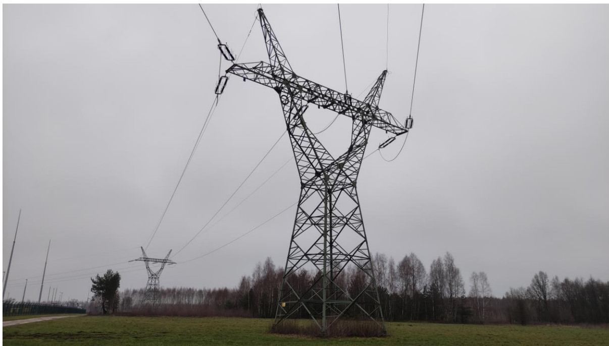
Zdjęcie nr 27. Widok na słup nr 229.
