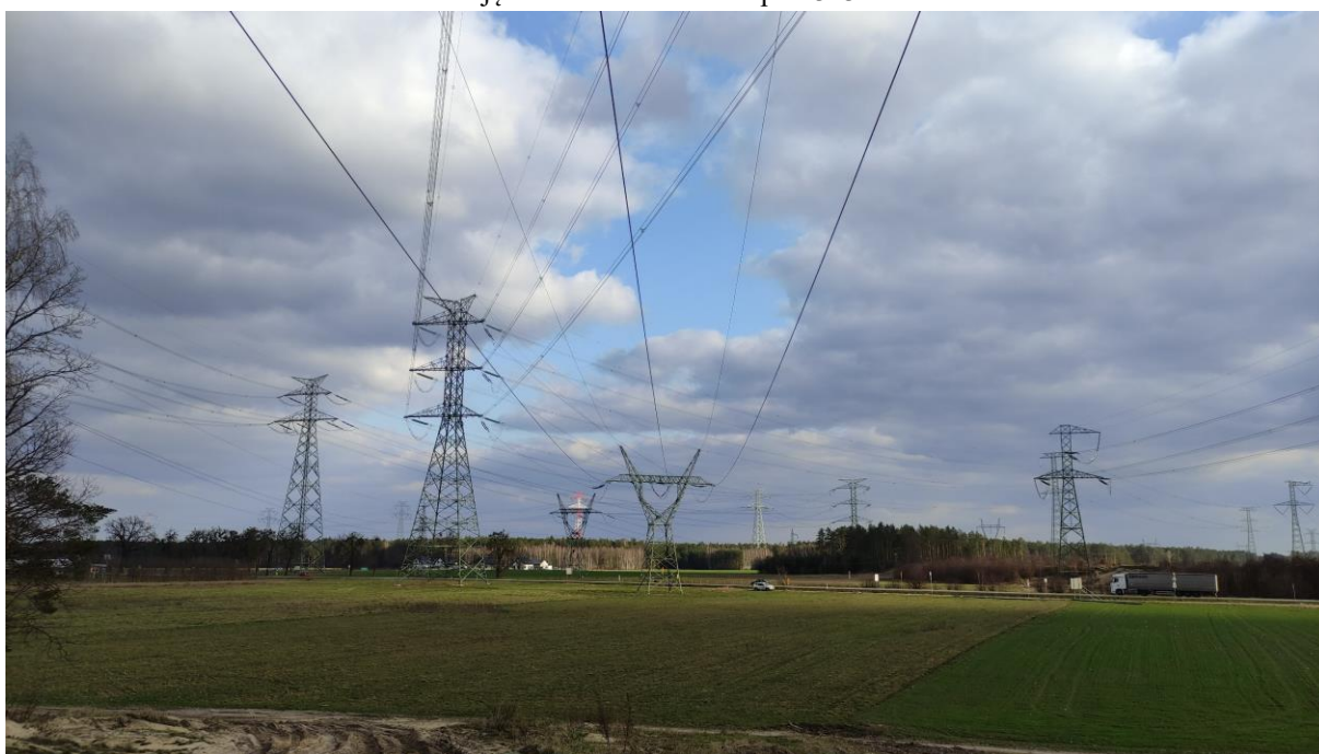
Zdjęcie nr 2. Widok na słup nr 323A.
