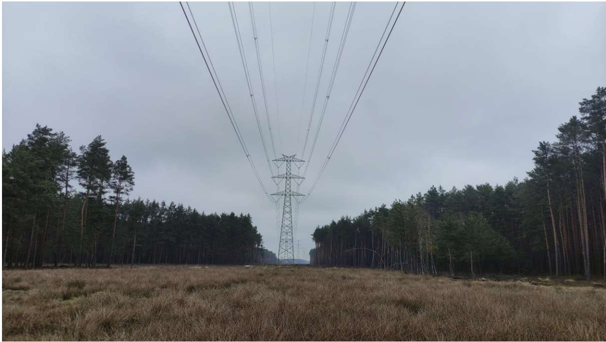
Zdjęcie nr 25. Widok na słup nr 205.
