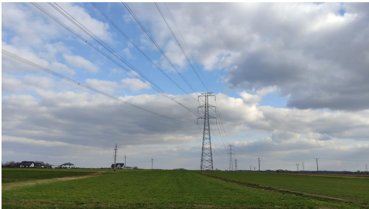
Zdjęcie nr 7. Widok na słup nr 17.
