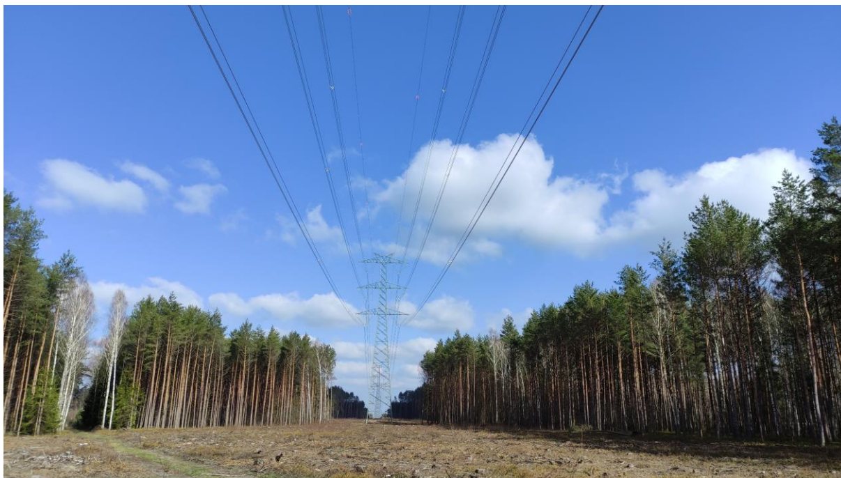
Zdjęcie nr 13. Widok na słup nr 116.
