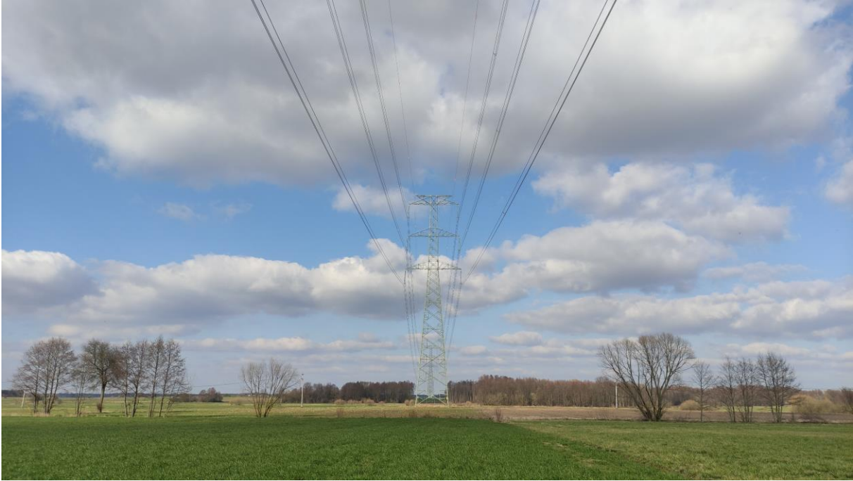
Zdjęcie nr 9. Widok na słup nr 42.
