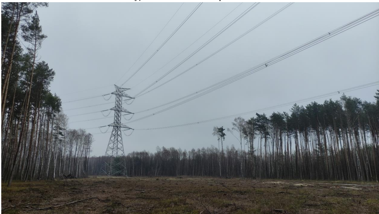
Zdjęcie nr 26. Widok na słup nr 228.
