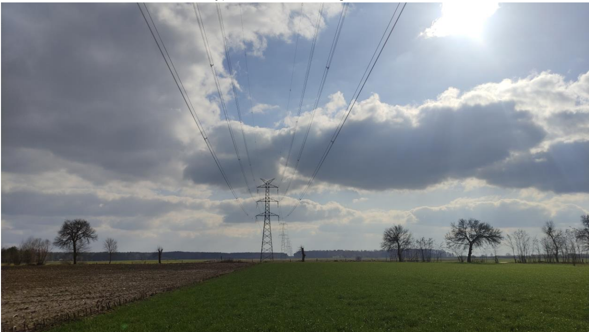
Zdjęcie nr 10. Widok na słup nr 43.
