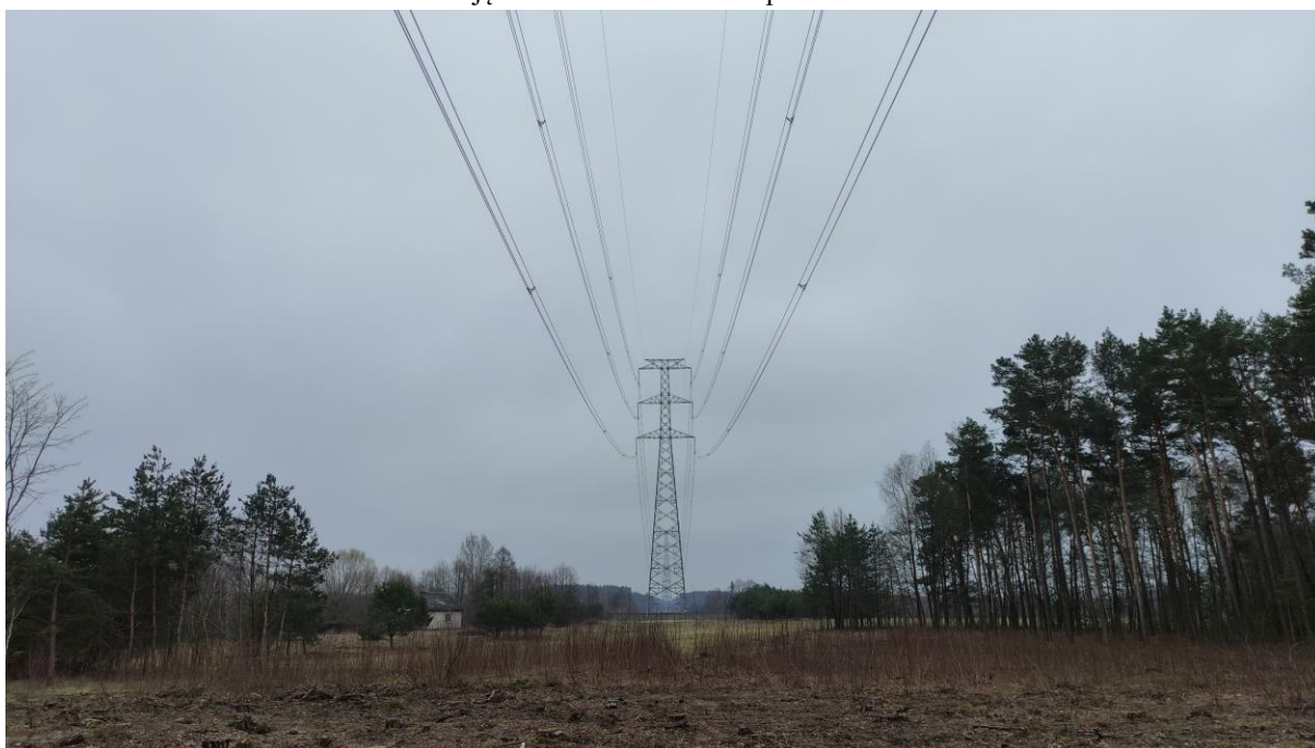
Zdjęcie nr 20. Widok na słup nr 174.
