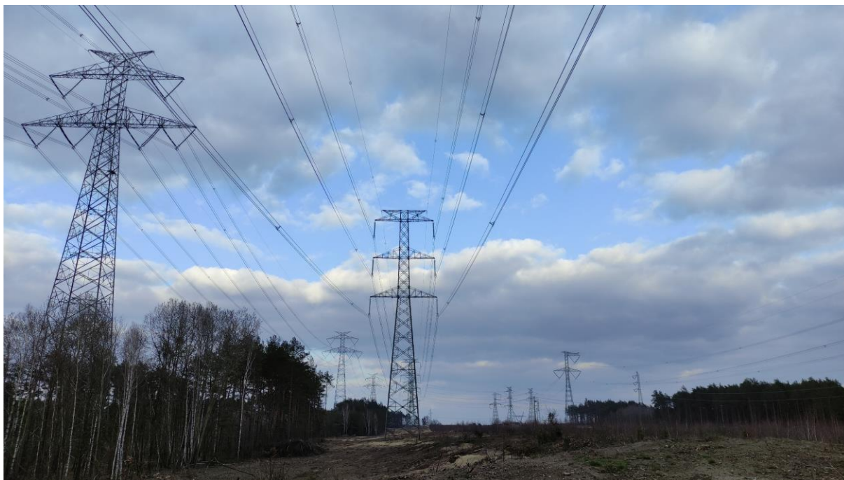
Zdjęcie nr 5. Widok na słup nr 2.
