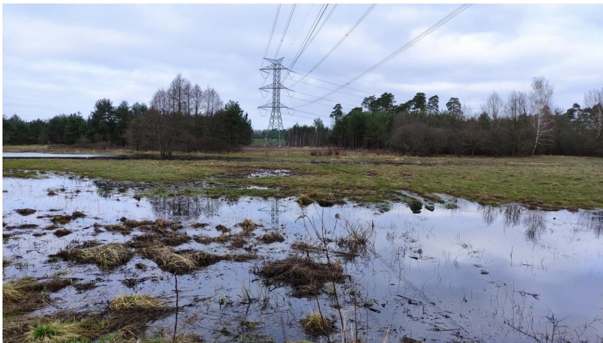
Zdjęcie nr 17. Widok na słup nr 145.
