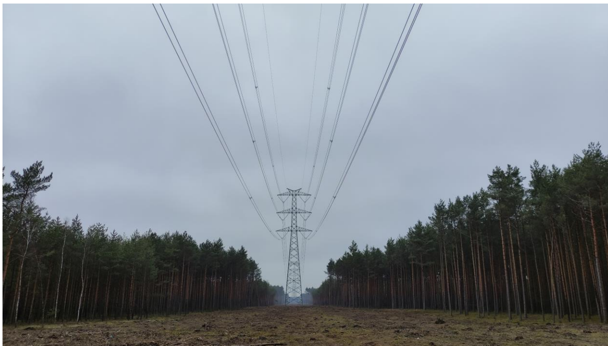
Zdjęcie nr 19. Widok na słup nr 173.
